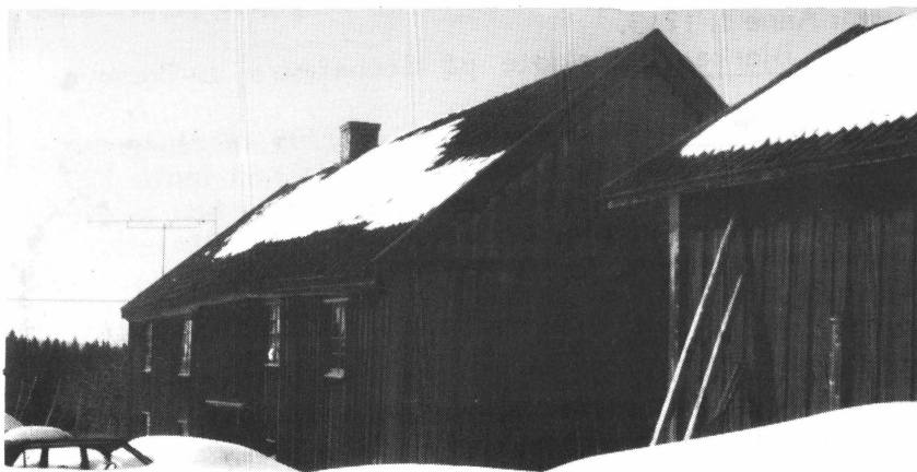
Den fredede bygningen på Ånnerud i Vestre Toten, fotografert vinteren 1987 av Arne Amundgård.
